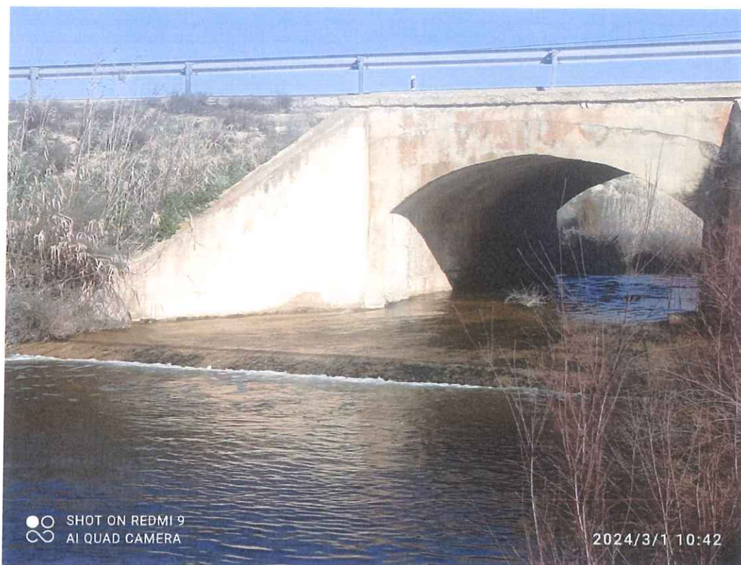
Foto 3: Cauce del rio Cigüela a su paso por la CM-3165 de Herencia a Alcázar de SJ aguas arriba
